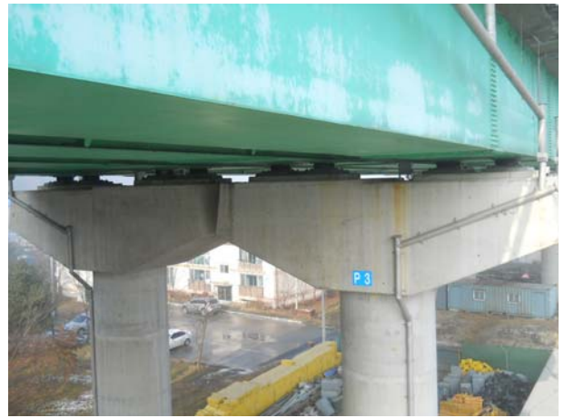
위 치 교각(P3) 내 용 교각 전경
