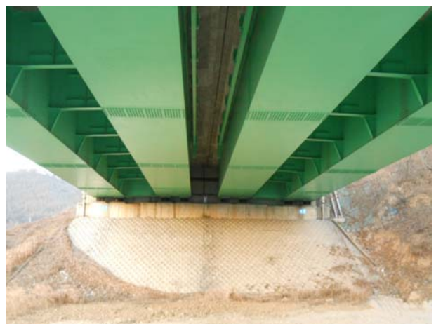
위 치 중점교대 내 용 교대 전경
