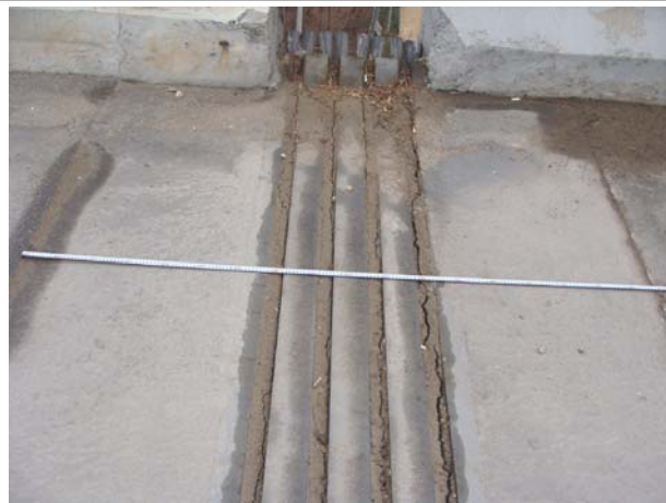
위 치 신축이음부(원주방향 P11 - 210mm) 내 용 유간측정 장면
