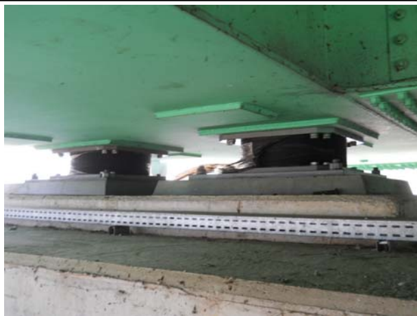
위 치 교좌장치(P3-원주방향 G2) 내 용 교좌장치 상태
