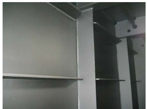
위 치 STEEL BOX(S14-원주방향 G2) 내 용 보강재 상태
