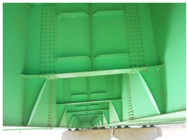
위 치 STEEL BOX(S27-양평방향) 내 용 가로보 상태
