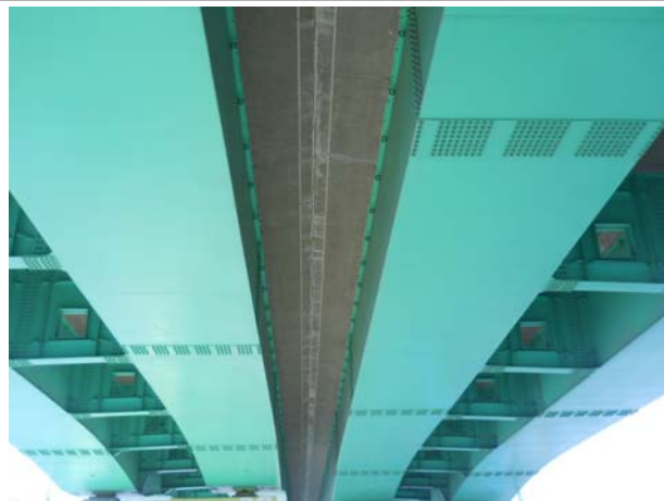
위 치 1경간 내 용 슬래브 하면 전경
