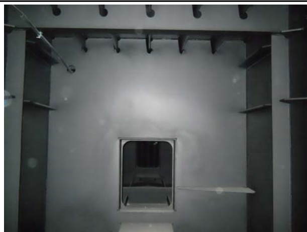
위 치 1경간 G3(양평방향) 내 용 STEEL BOX 내부 상태
