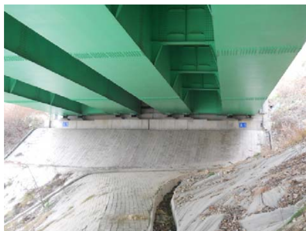
위 치 시점교대 내 용 교대 전경
