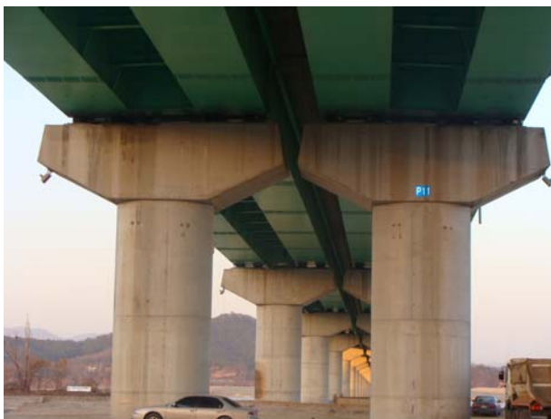
위 치 교각(P11) 내 용 교각 전경
