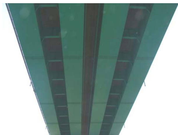
위 치 슬래브하면(S6) 내 용 슬래브하면 전경
