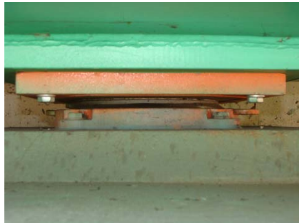
위 치 A2(원주방향) 내 용 BR4 교좌장치 상태
