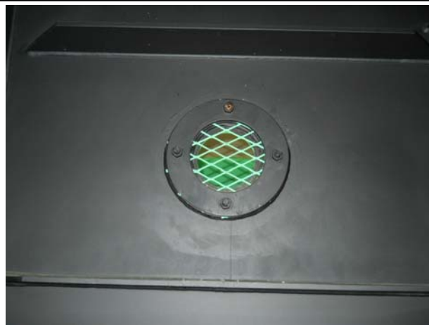
위 치 STEEL BOX(S5-양평방향 G1) 내 용 환기구 상태
