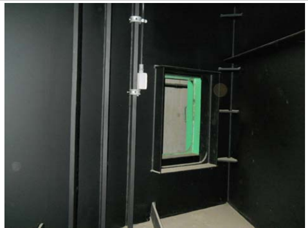
위 치 1경간 G2(양평방향) 내 용 입구부 상태
