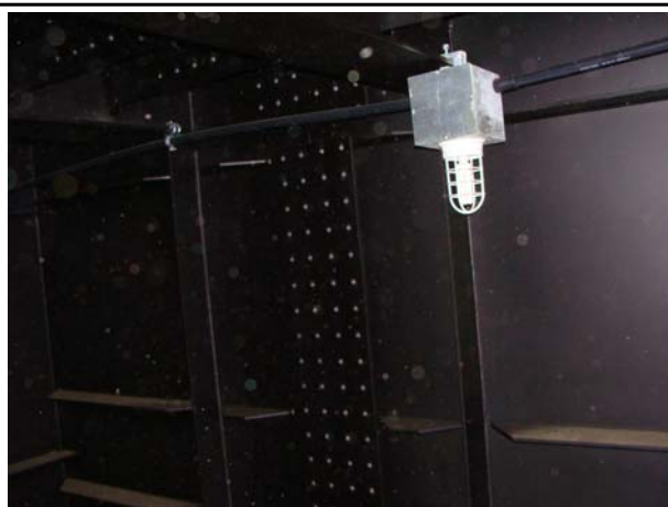
위 치 G2(양평방향) 내 용 볼트체결 상태
