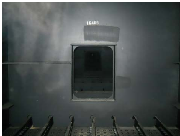
위 치 STEEL BOX(S1-양평방향 G1) 내 용 STEEL BOX 내부 상태
