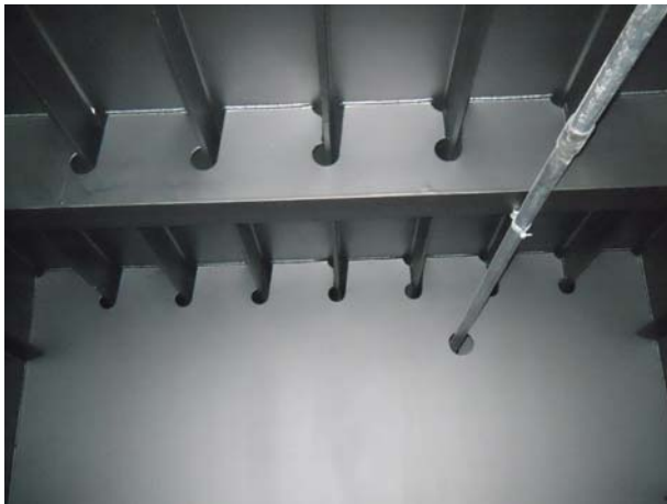
위 치 STEEL BOX(S23-원주방향 G1) 내 용 보강재 상태
