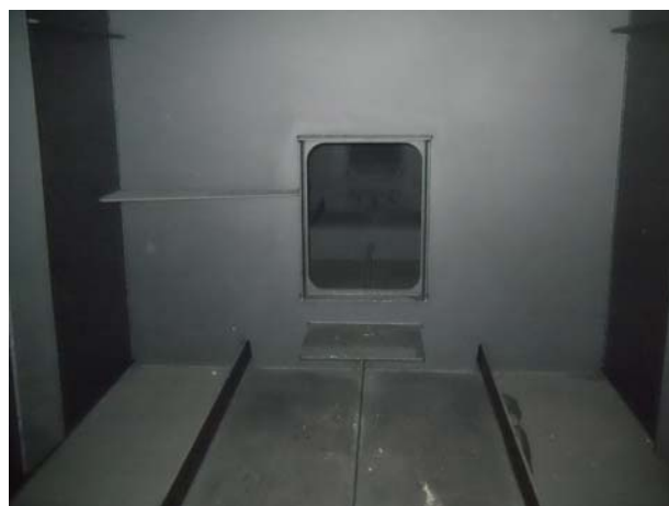
위 치 STEEL BOX(S9-원주방향 G1) 내 용 다이아프램 상태
