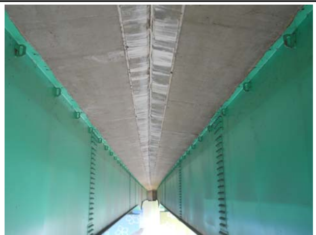
위 치 2경간 내 용 중앙부 콘크리트 상태
