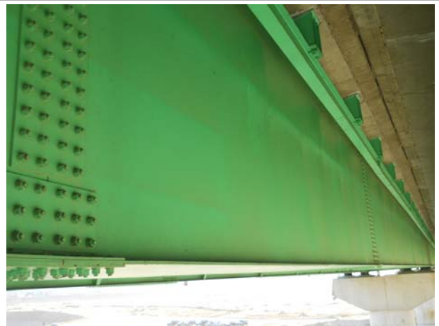
위 치 STEEL BOX(S15-원주방향 G2) 내 용 STEEL BOX 외부 상태
