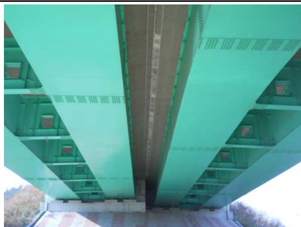
위 치 3경간 내 용 슬래브 하면 전경
