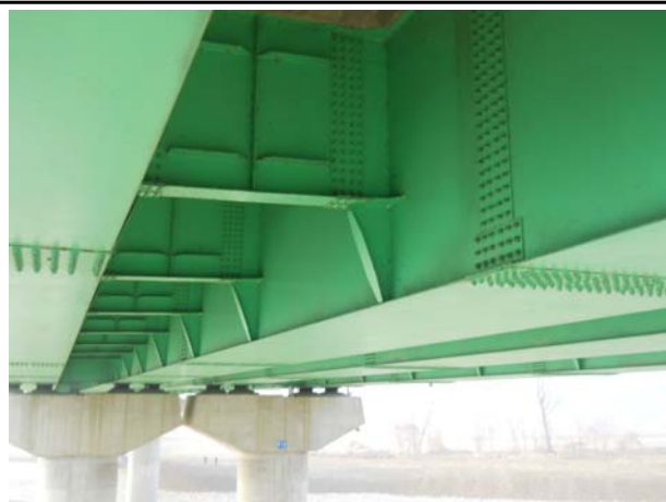
위 치 STEEL BOX(S17) 내 용 STEEL BOX 외부 상태
