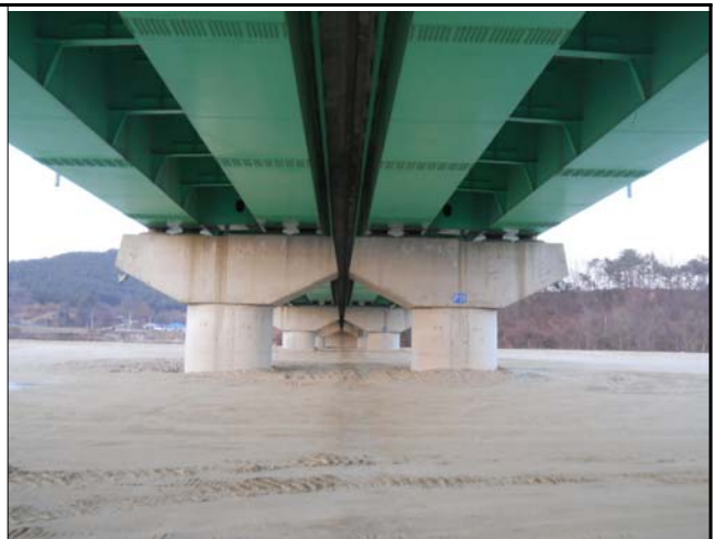
위 치 교각(P29) 내 용 교각 전경
