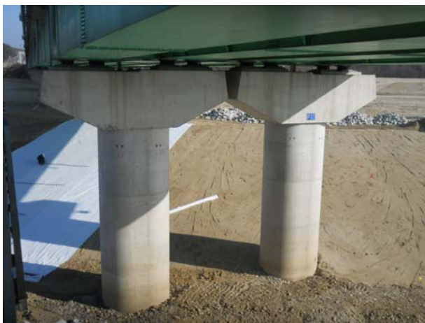
위 치 교각(P27) 내 용 교각 전경
