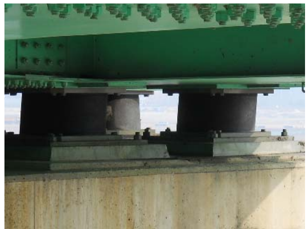
위 치 교좌장치(P18-양평방향 G2) 내 용 교좌장치 상태
