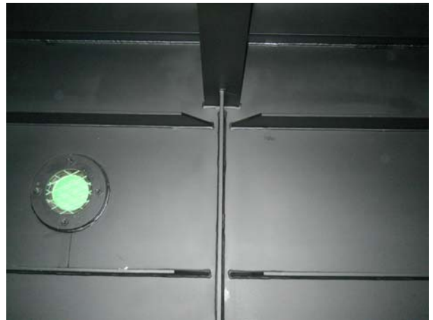
위 치 STEEL BOX(S25-양평방향 G2) 내 용 용접 상태
