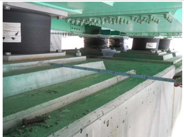
위 치 STEEL BOX(S28-양평방향 G2) 내 용 연단거리 측정 장면
