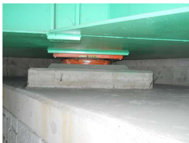
위 치 1경간 A1(원주방향) 내 용 BR1 교좌장치 상태
