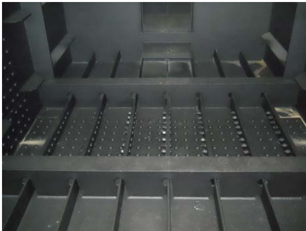
위 치 STEEL BOX(S17-양평방향 G1) 내 용 보강재 및 볼트체결 상태
