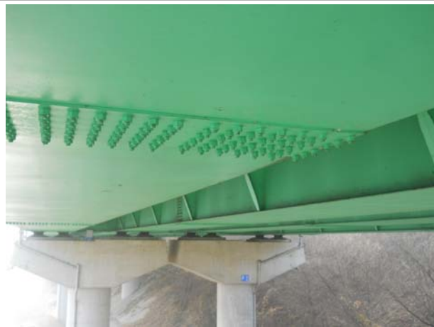
위 치 STEEL BOX(S3) 내 용 STEEL BOX 외부 상태
