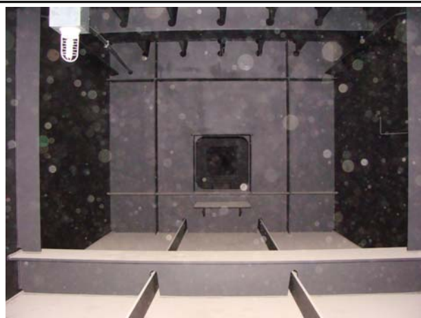
위 치 G1(양평방향) 내 용 STEEL BOX 내부 전경
