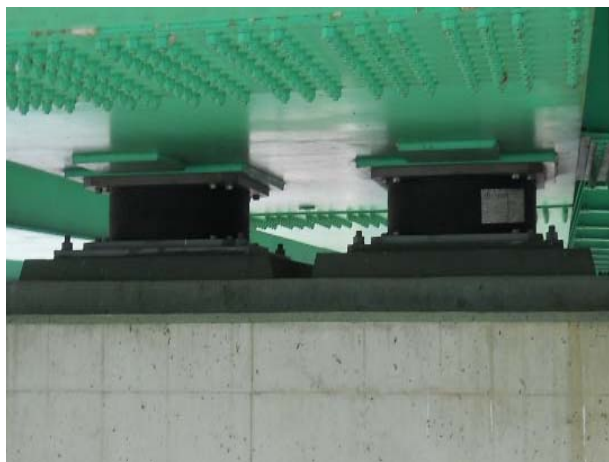
위 치 교좌장치(P15-양평방향 G1) 내 용 교좌장치 상태
