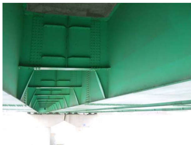
위 치 STEEL BOX(S23-원주방향) 내 용 가로보 상태
