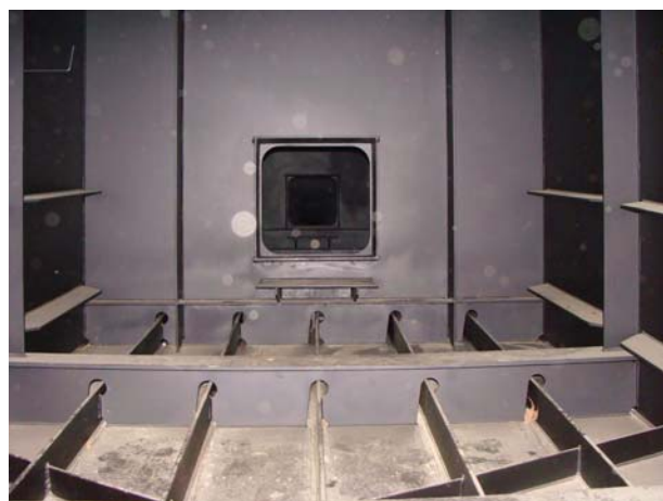
위 치 G2(원주방향) 내 용 STEEL BOX 내부 전경
