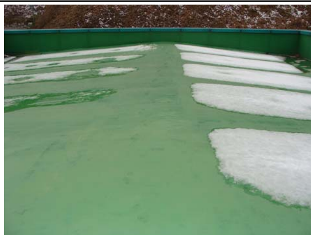
위 치 관리동 2층 내 용 외부 전경
