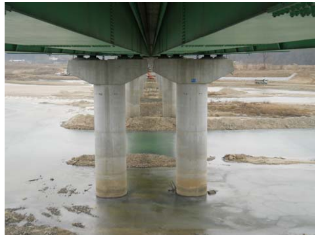
위 치 교각(P19) 내 용 교각 전경
