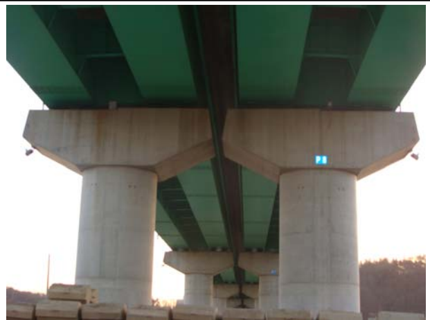
위 치 교각(P8) 내 용 교각 전경
