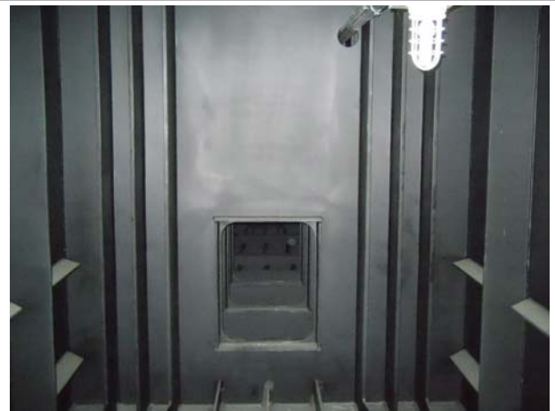
위 치 STEEL BOX(S5-원주방향 G2) 내 용 STEEL BOX 내부 상태
