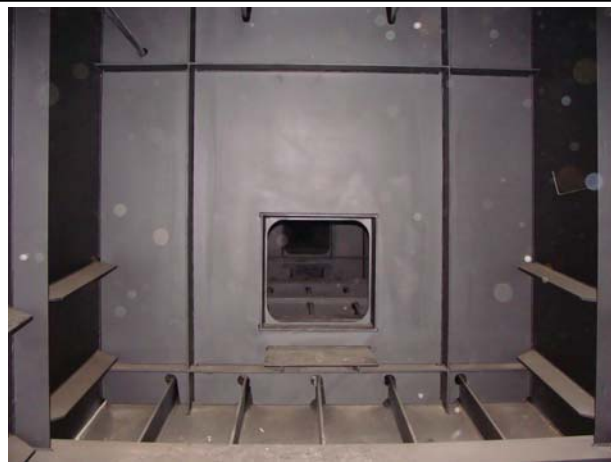
위 치 G1(원주방향) 내 용 STEEL BOX 내부 전경
