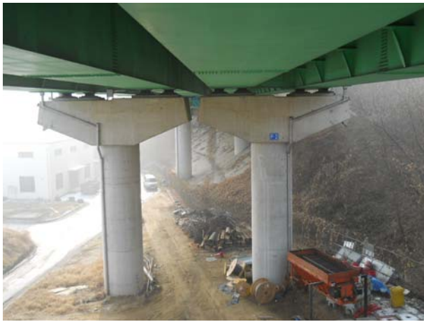
위 치 교각(P2) 내 용 교각 전경
