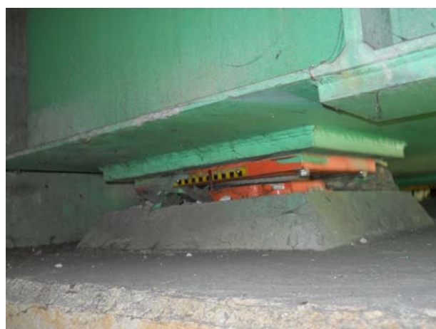
위 치 A1(원주방향) 내 용 BR1 교좌장치 상태
