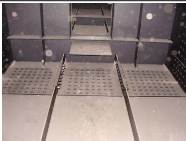
위 치 G1(양평방향) 내 용 볼트체결 상태
