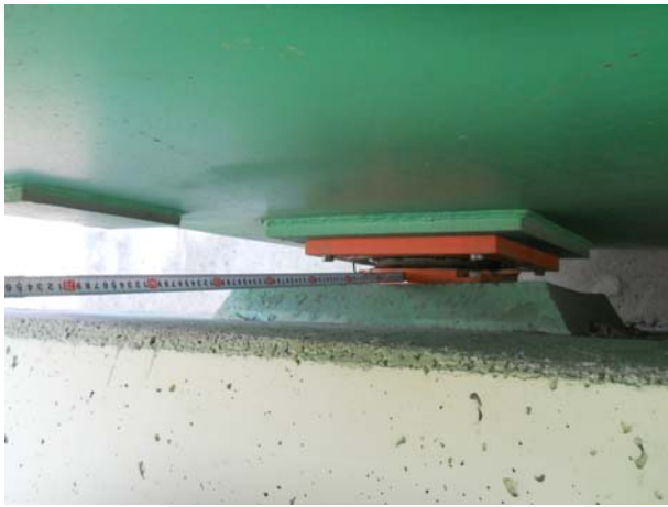
위 치 1경간 A1(양평방향) 내 용 BR4 교좌장치 연단거리 측정 장면
