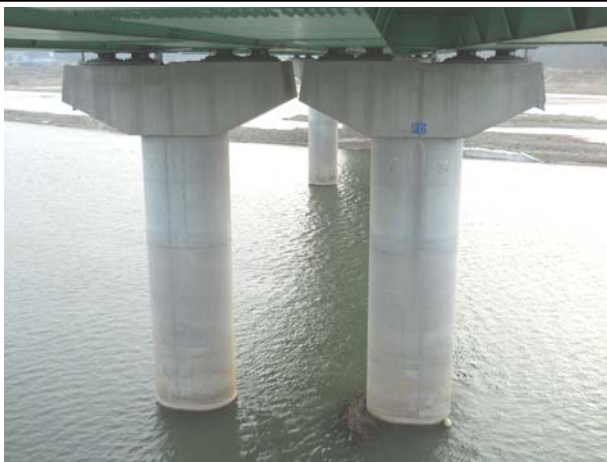
위 치 교각(P22) 내 용 교각 전경
