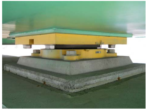
위 치 1경간 P1(양평방향) 내 용 BR1 교좌장치 상태
