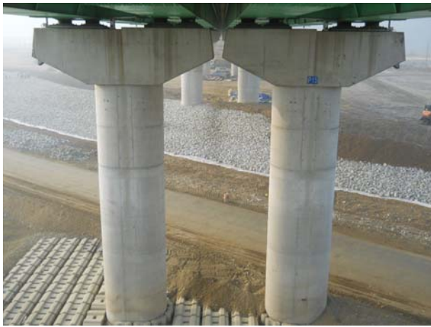
위 치 교각(P15) 내 용 교각 전경
