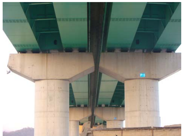
위 치 교각(P13) 내 용 교각 전경
