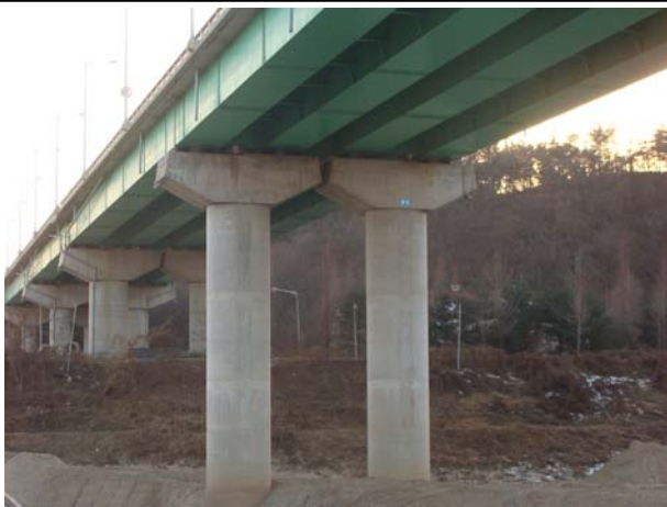
위 치 교각(P5) 내 용 교각 전경
