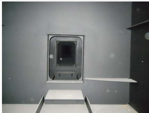
위 치 1경간 G2(양평방향) 내 용 STEEL BOX 내부 상태
