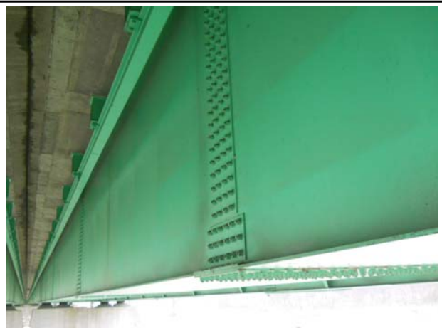
위 치 STEEL BOX(S20-양평방향 G2) 내 용 STEEL BOX 외부 상태
