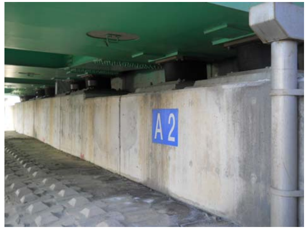
위 치 교좌장치(A2) 내 용 교좌장치 상태
