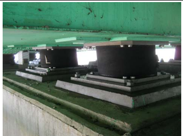
위 치 교좌장치(P4-원주방향 G1) 내 용 교좌장치 상태
