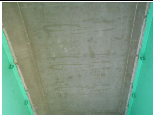
위 치 슬래브하면(S3-원주방향) 내 용 슬래브하면 전경
