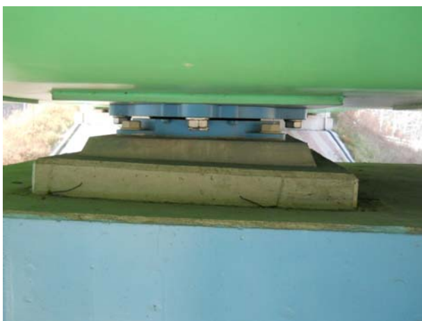
위 치 1경간 P2(양평방향) 내 용 BR1 교좌장치 상태
