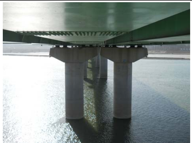
위 치 교각(P25) 내 용 교각 전경
