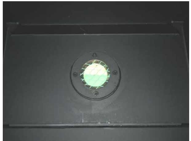
위 치 STEEL BOX(S21-양평방향 G2) 내 용 환기구 상태
