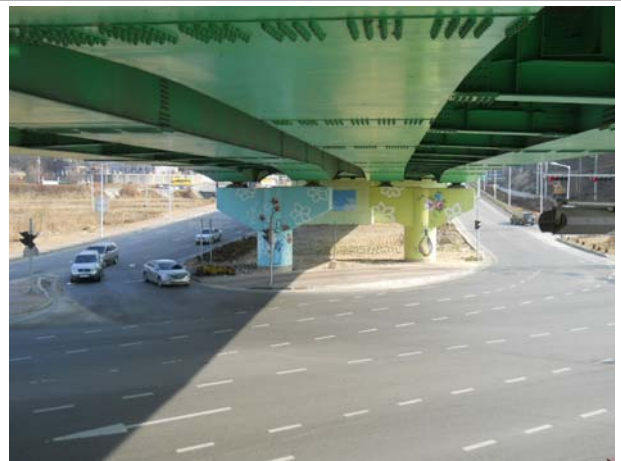
위 치 2경간 내 용 슬래브 하면 전경
